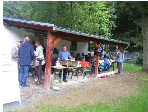
Das neue Vordach
